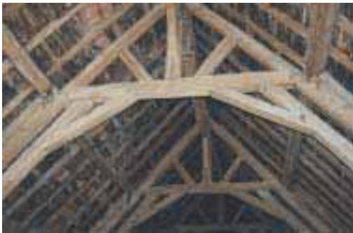
Charpente des écuries ouest avant leur transformation en médiathèque
