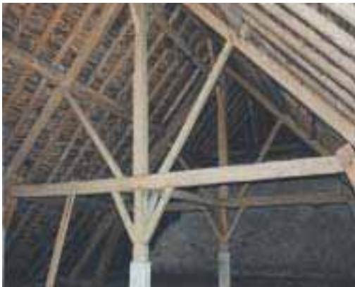
Charpente du musée
