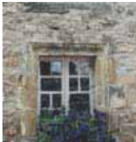
Fenêtre de la médiathèque: état ancien.
