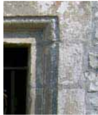
Détail d'un encadrement de fenêtre: quart-de-rond et filet propre au XVI e siècle.
