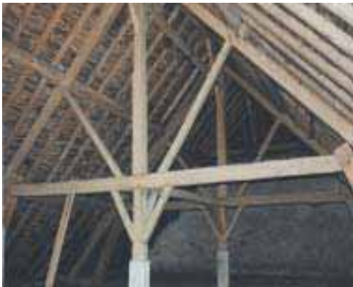
Charpente du musée
